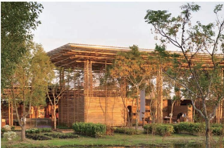
雲林農博公園的碳匯林場之竹建築，將竹材做垂直水平層次堆疊，以螺桿鎖固竹接頭的方式交錯構築出中式建築樣式的斗拱。（圖／大藏聯合建築師事務所）
