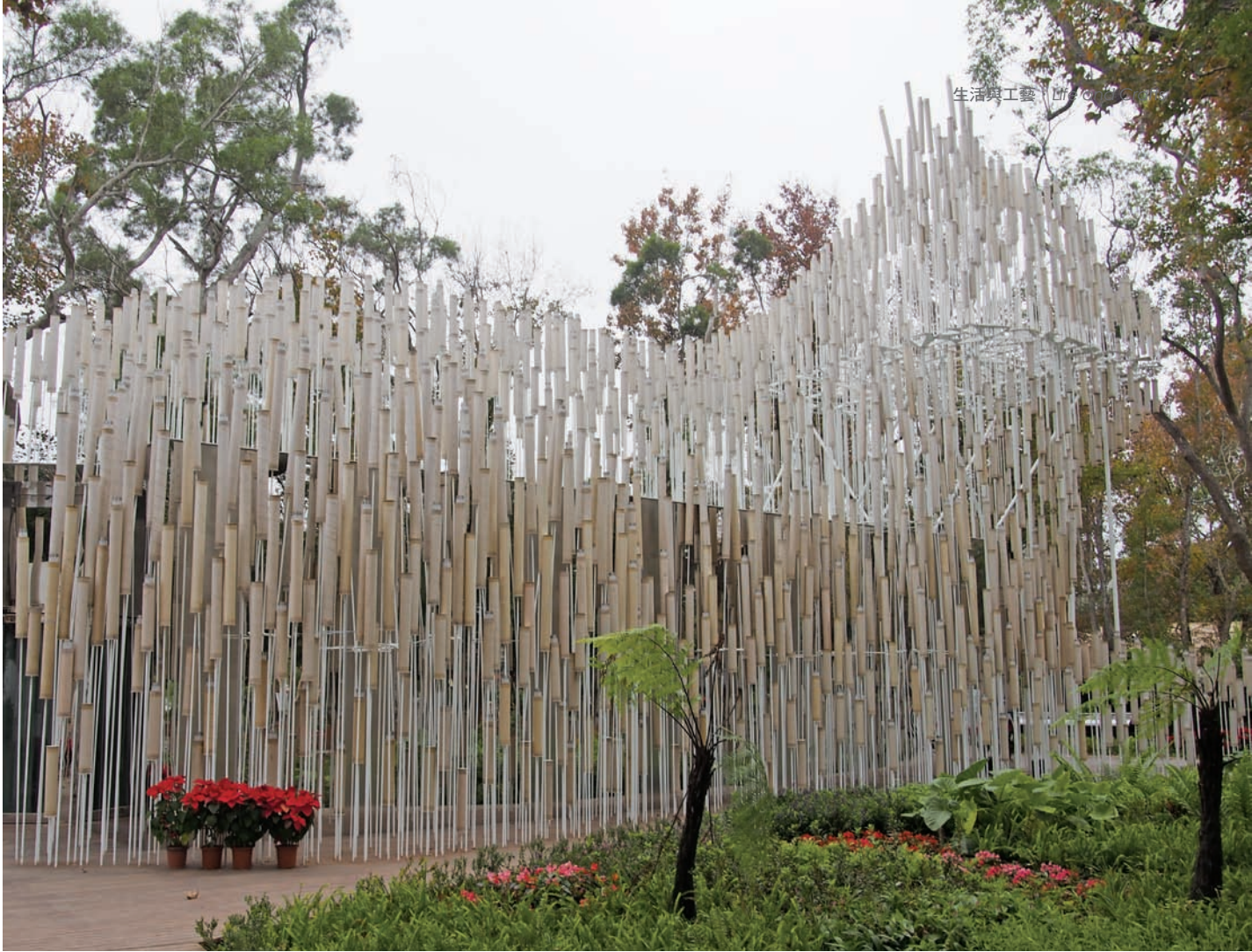
「森隆活虎館」以募集回收的瓦楞紙製成紙管，將展館打造為臺灣石虎的外型，回應環境保育與自然的意旨。
