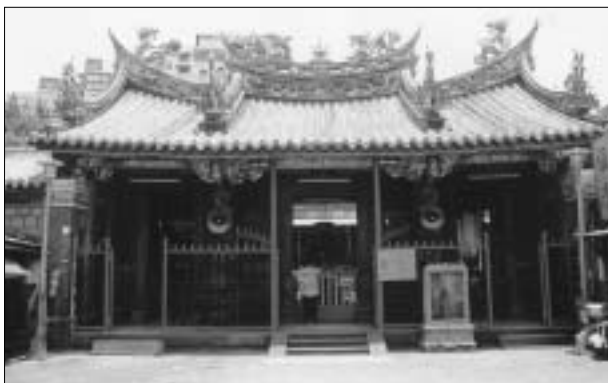
9.台灣廟宇早年習慣將前殿屋脊中段提高，成為「三川脊」造型，表現出傳統建築中「正偏」的空間觀念（艋舺清水巖）。
