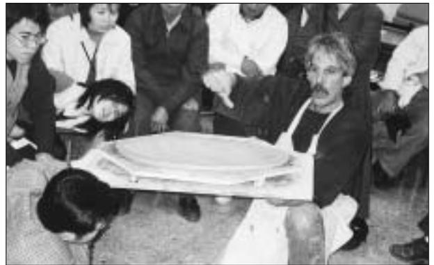
圖6：製做大盤子的簡單方法——利用中空型板墊好固定高度，讓土板邊沿托高，內部下垂。
