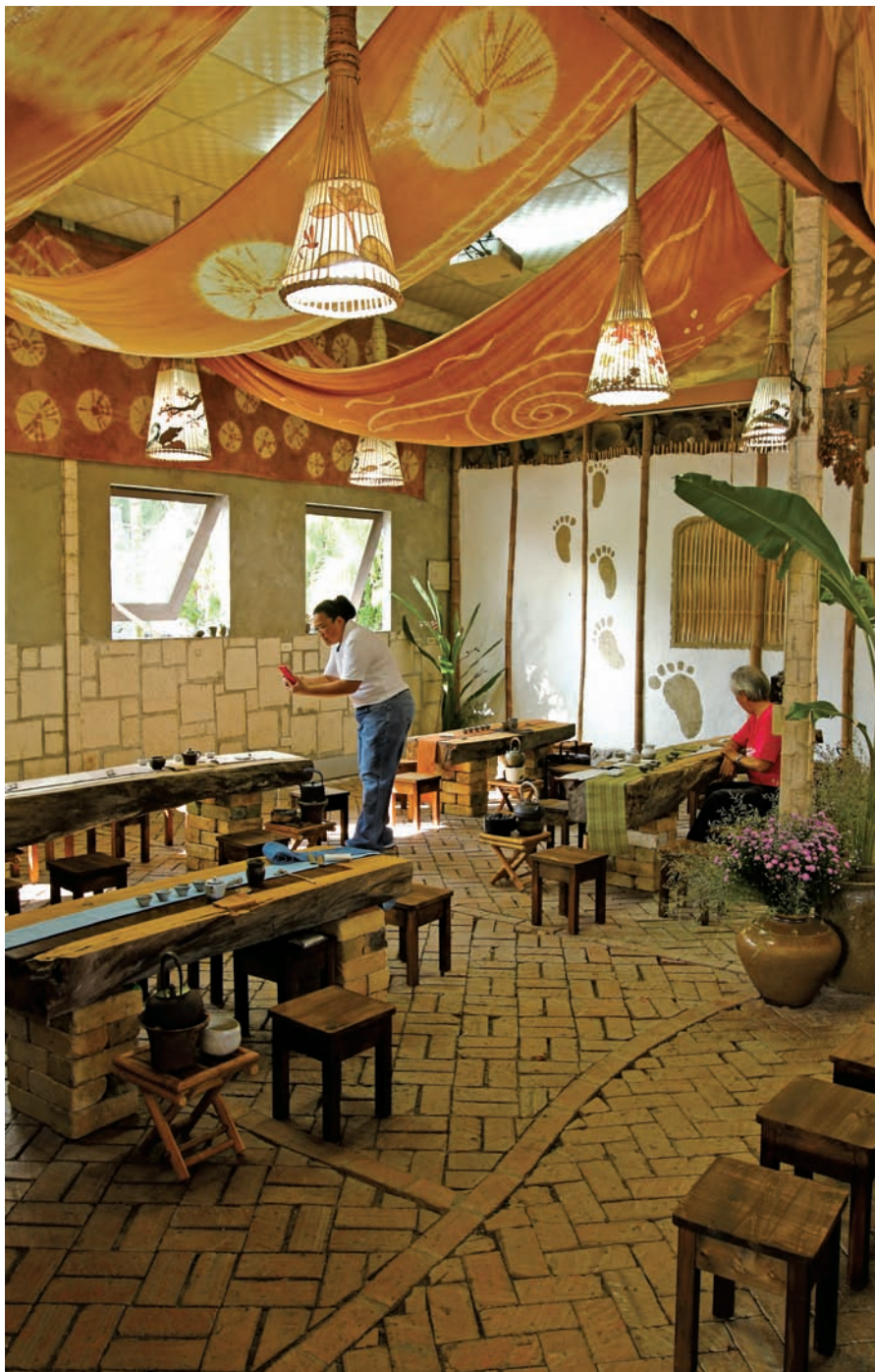
「槎仔腳文化共享空間」的建築修繕採自然工法和元素，由居民們協力完成，包括讓室內降溫的綠屋頂、防潮透氣的地上鋪磚等，讓環境更加環保、舒適自然。
