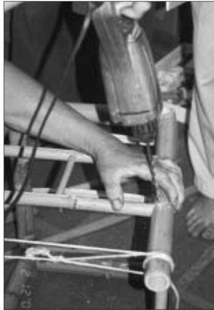
在各接合點打竹釘前先用手電鑽引洞
