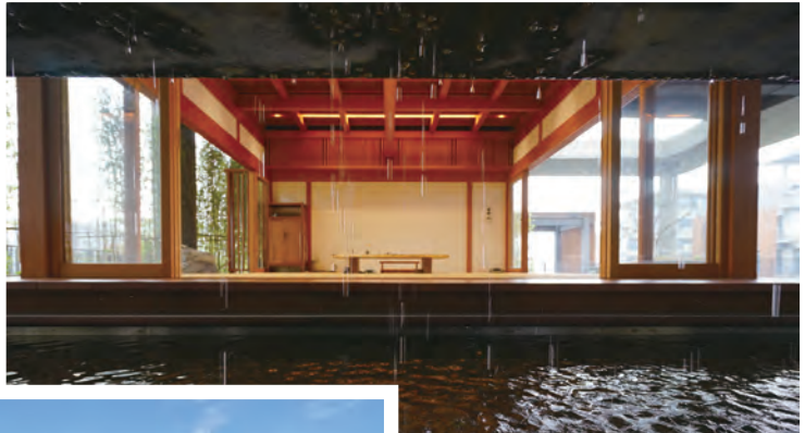
中國廣東省深圳市梧桐島茶屋一榫接木構的組裝效率高，能以裝櫃運送。現場施工再以簡單的輔助機具，透過師傅的巧手，將每一個零件放到對的位置上即大功告成。
