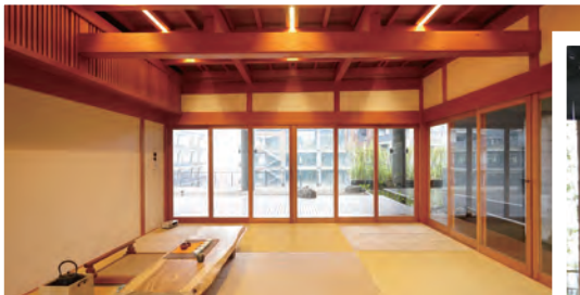
中國廣東省深圳市梧桐島茶屋一榫接木構的組裝效率高，能以裝櫃運送。現場施工再以簡單的輔助機具，透過師傅的巧手，將每一個零件放到對的位置上即大功告成。
