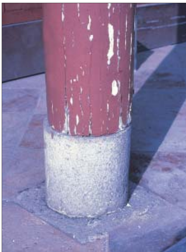
圖3. 彰化孔廟柱礎下加墊「磧」
