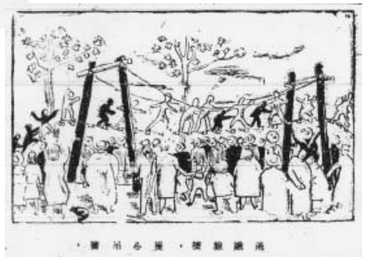
過鐵線橋，提心吊膽：登於1947年1月26日中華日報。此速寫畫的是土木系搭建的鐵索橋。(提供／陳凱劭)
