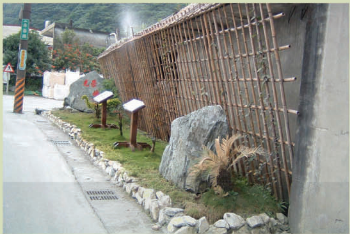
工廠外圍竹籬美化與防塵裝置
