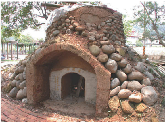
石灰窯煉製石灰提供泡取竹木纖維，以製造紙漿。
