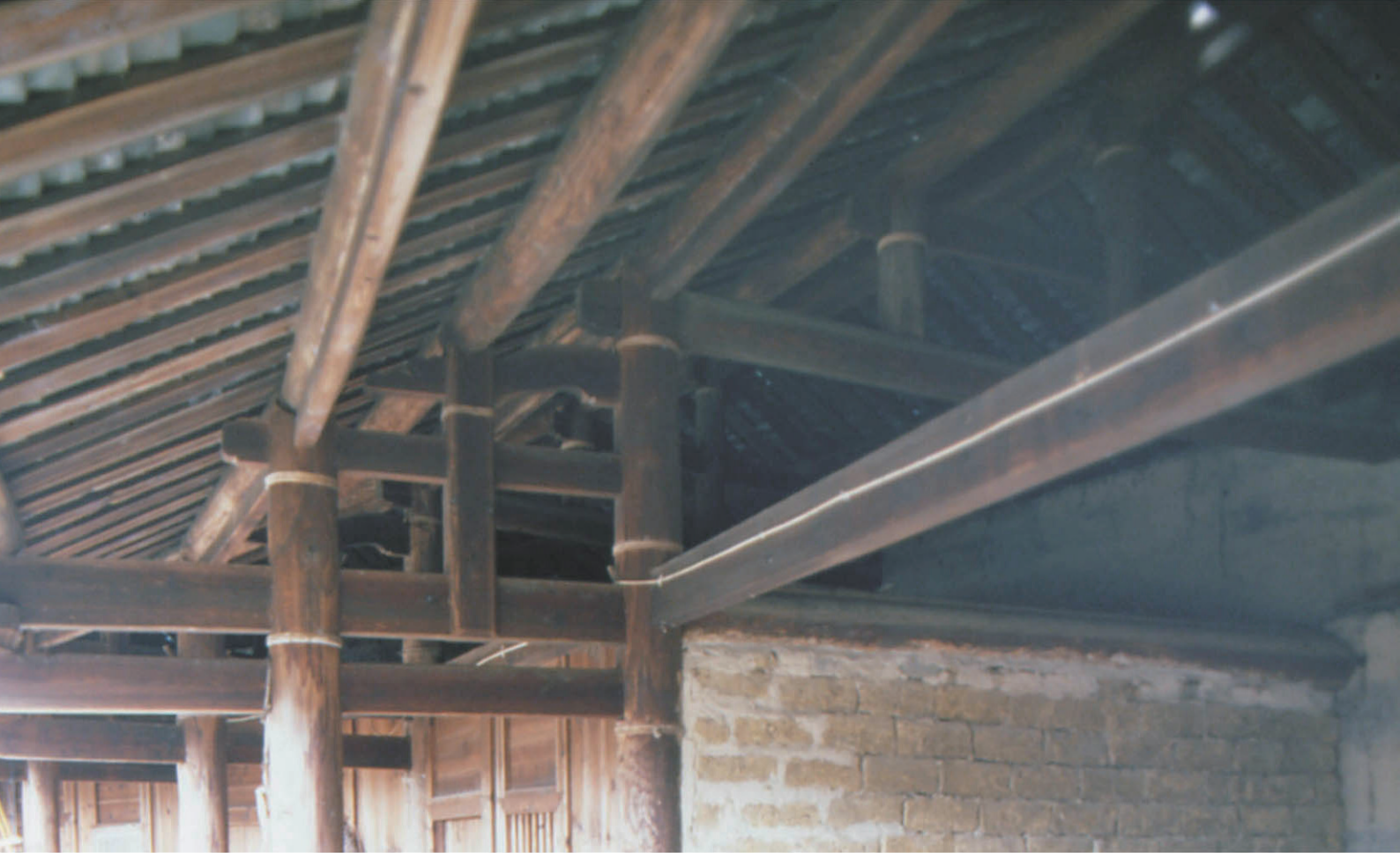
閩西客家土樓集居形式中的穿斗式木屋架。顯示整體結構性榫卯接合的忠實表現。
