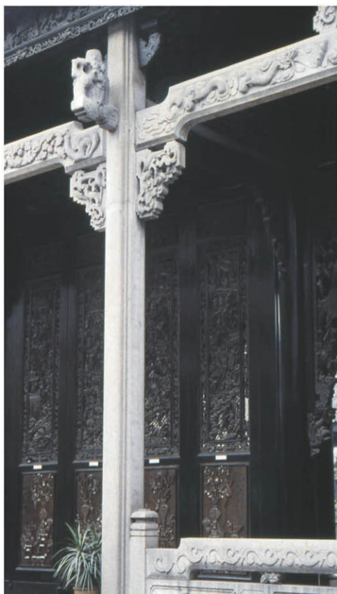
廣州·陳氏書院。大量運用仿木構造的工法來構築石構造檐廊的柱樑和裝飾系統。顯示榫卯工藝在木、石構造上仍有其互通性。
