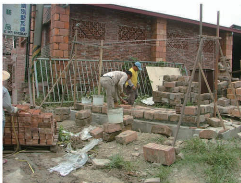
入口意象牆體施工。
