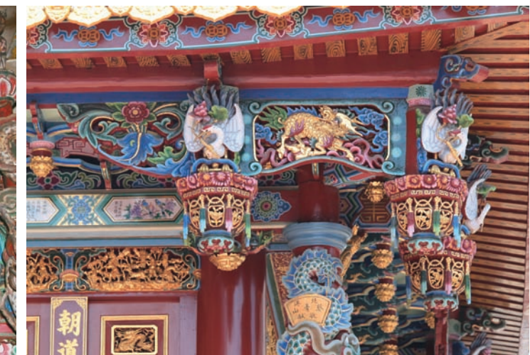
北港朝天宮鐘鼓樓以翻模製作的垂花吊筒
