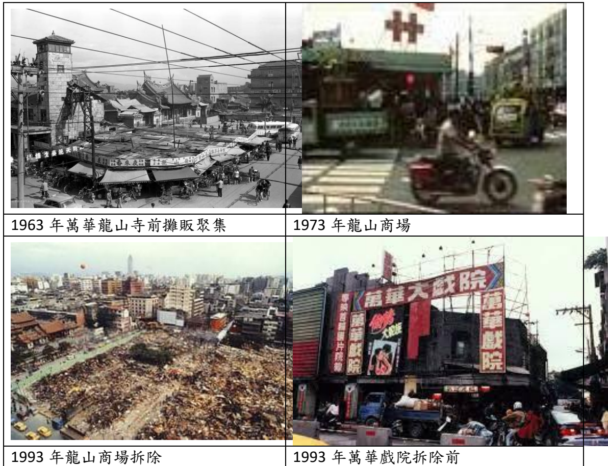
圖2-17 龍山商場興建前後及拆除照片
