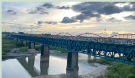
市定古蹟「嘉南大圳曾文溪渡槽橋」
