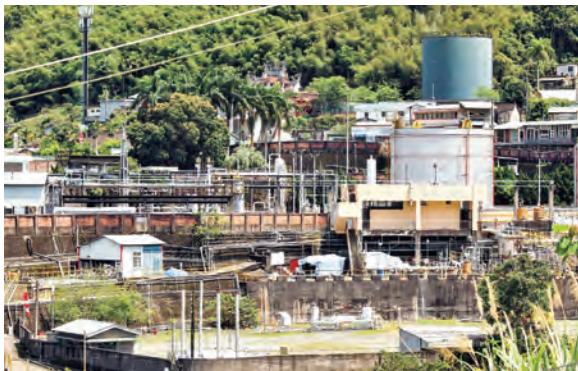
圖 7. 油氣處理中心 Fig 7. Oil and Gas Processing Facility. 資料來源：本研究拍攝。
