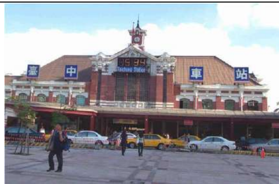
圖 2-20 臺中火車站修復前
