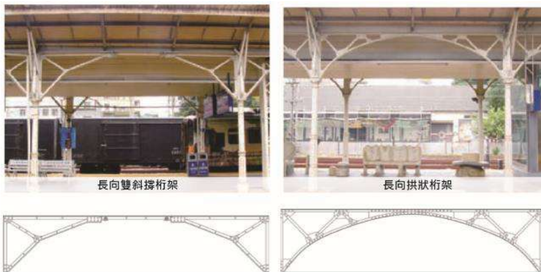
圖 2-16 臺中火車站桁架形式
