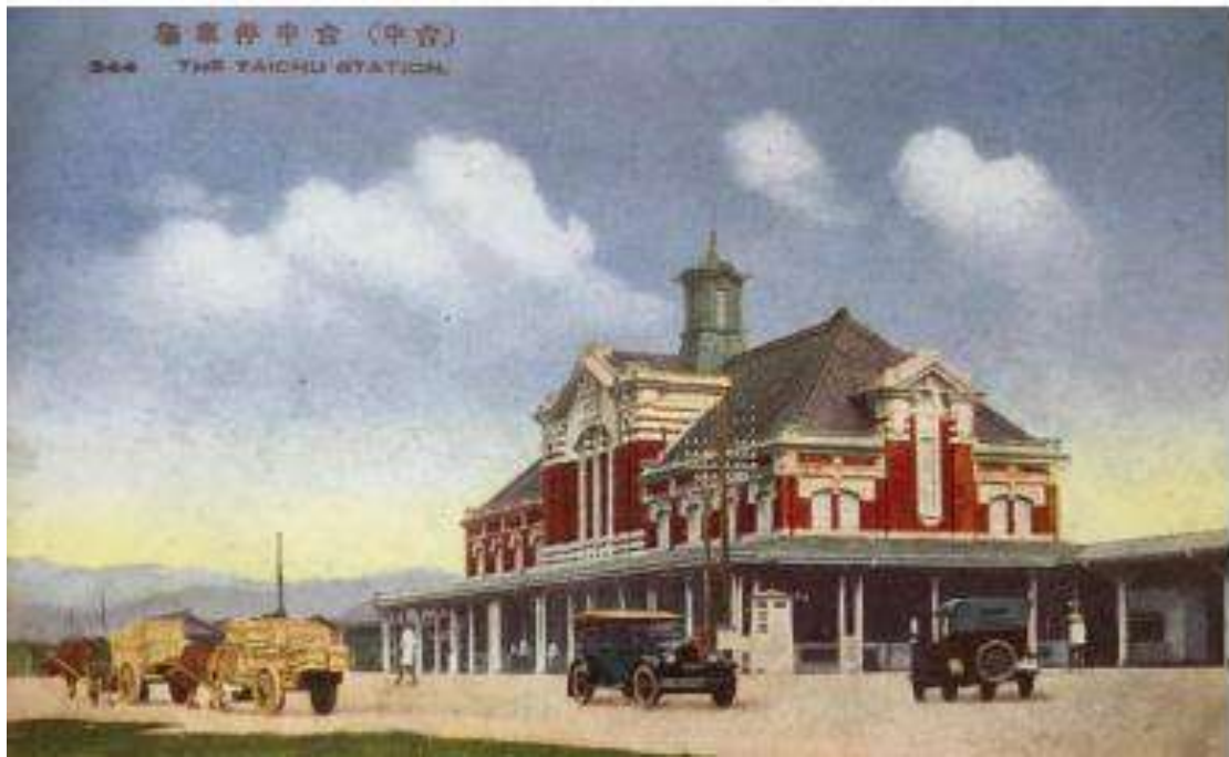
圖 2-3 日治時期的臺中火車站
