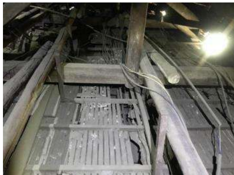
圖 2-50 事務室天花板現況
