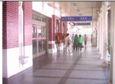
圖 2-21 臺中火車站修復前
