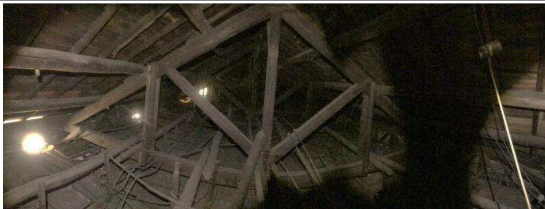
圖 2-49 第一代臺中停車場事務室屋架現況
