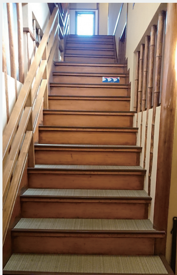
■日本 311 海嘯水位到達高度，宮城縣古宅災後復原特別標示水位高度
