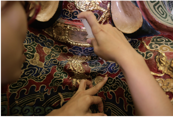
■ 圖 24. 空鼓處使用注射筒灌注加固 Figure 24. Consolidation of voids by injecting acrylic resin
