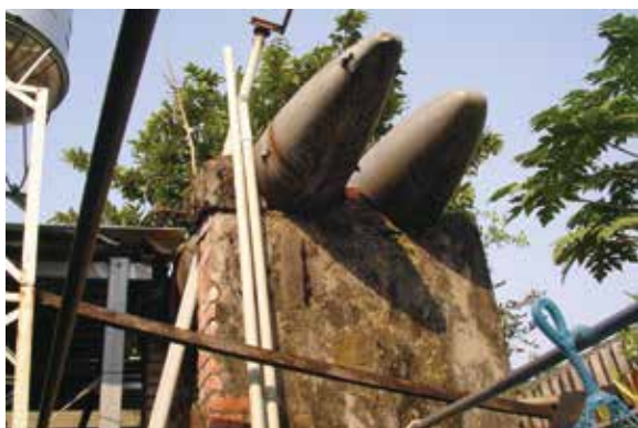
▲圖3. 擁有兩個副油箱的水塔。
