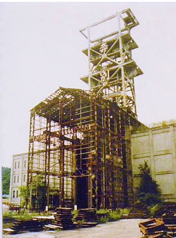
圖 1：住友奔別煤礦的直井，建於 1960 年（高 52 公尺，東方最大的直井）。（照片來源：山田大隆）
