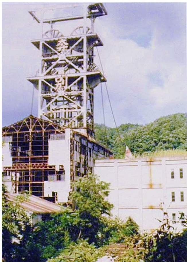
圖 1：住友奔別煤礦的直井，建於 1960 年（高 52 公尺，東方最大的直井）。（照片來源：山田大隆）
