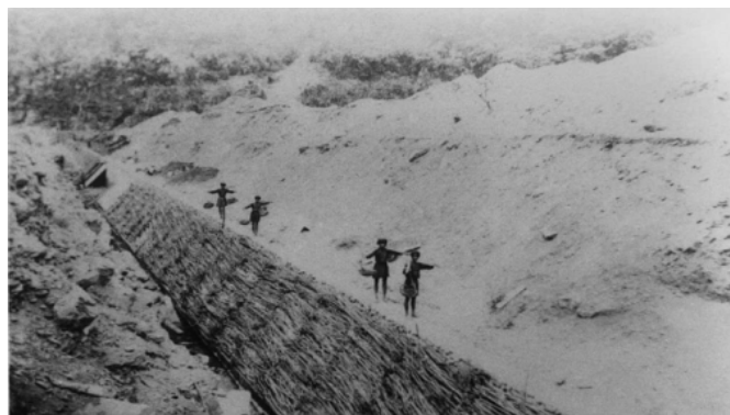
圖 3：二峰圳梯型堰堤鋪上埔姜當過濾層，拍攝於 1922 到 1923 年之間（圖片來源：臺糖公司）
