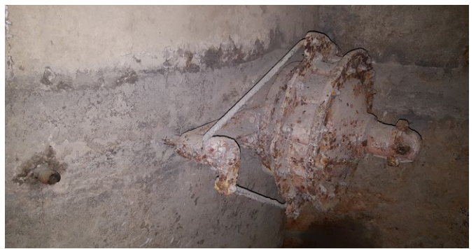
圖 3：在扇平發電室發現了開槽式（open flume）法蘭西斯式水輪機的橫軸，並將之清理乾淨
